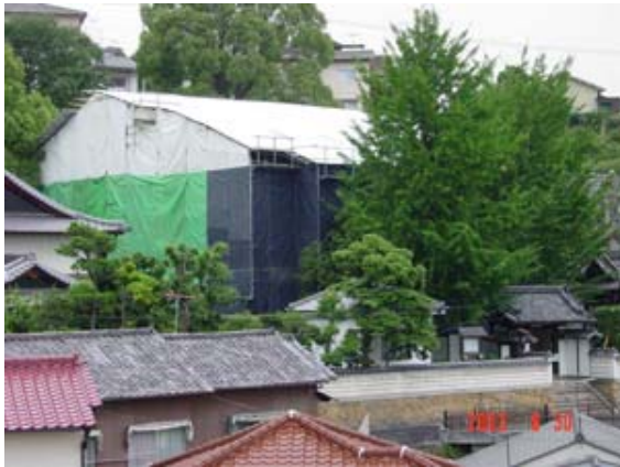
本堂をすっぽり覆う素屋根も完成
