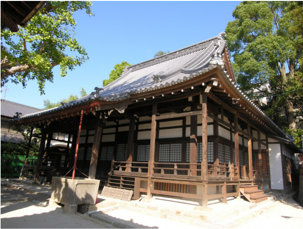
遂に完成した長ノ木本坊本堂
